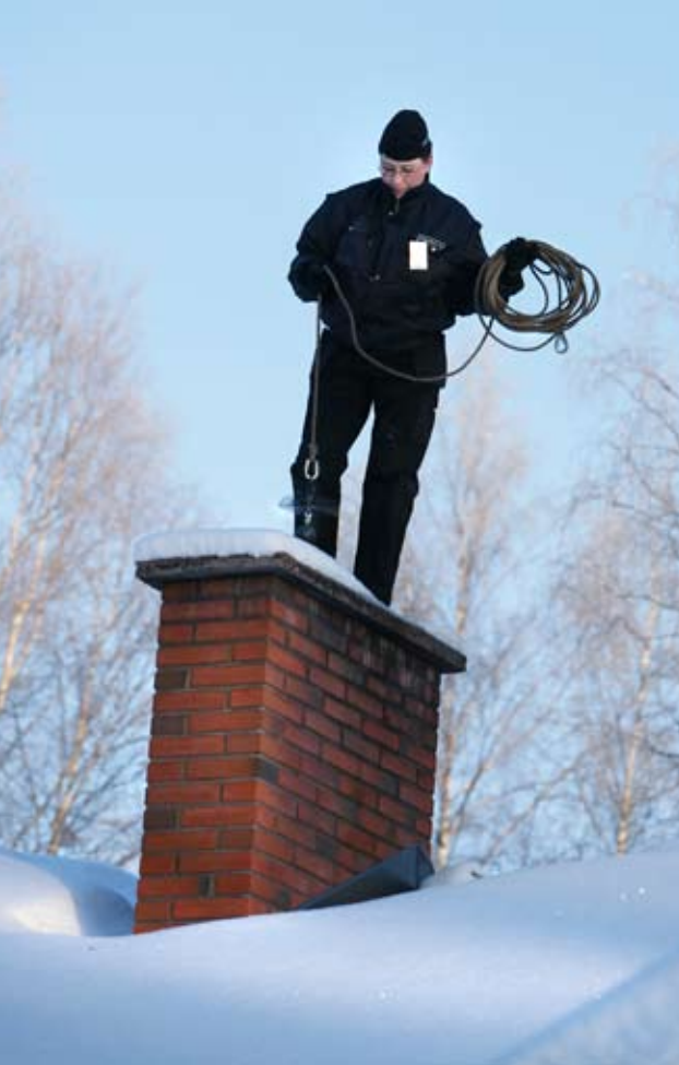
Nuohousvaijerien ja vaijeriharjojen avulla puhdistetaan tulisijan savunkierto. Jäykällä vaijerilla saadaan harjattua savunkierto huolellisesti. Nuohoojamestari Anne Aalto puhdistamassa tulisijaa. Kuvat: Pekka Mäkinen/Nuohousalan Keskusliitto
